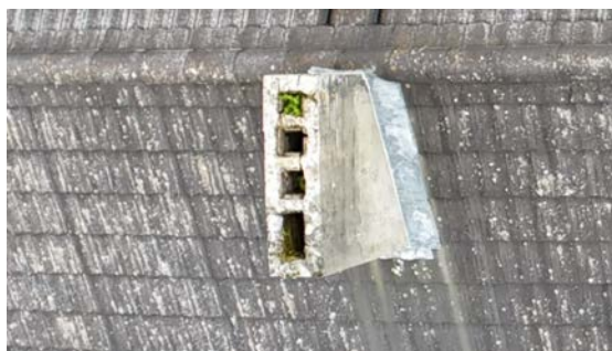
Pipe/lufteløp ser ut til å være delvis tett.
