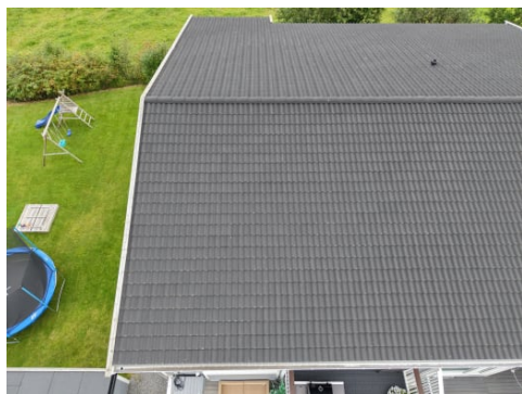
Taket er tekket med betongstein.
