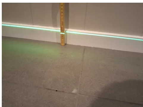
Etasjeskillet er kontrollert med nivelleringslaser.
