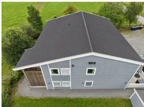
Boligen er oppført med saltakskonstruksjon.
