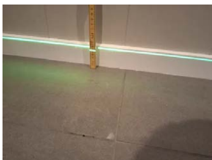
Etasjeskillet er kontrollert med nivelleringslaser.
