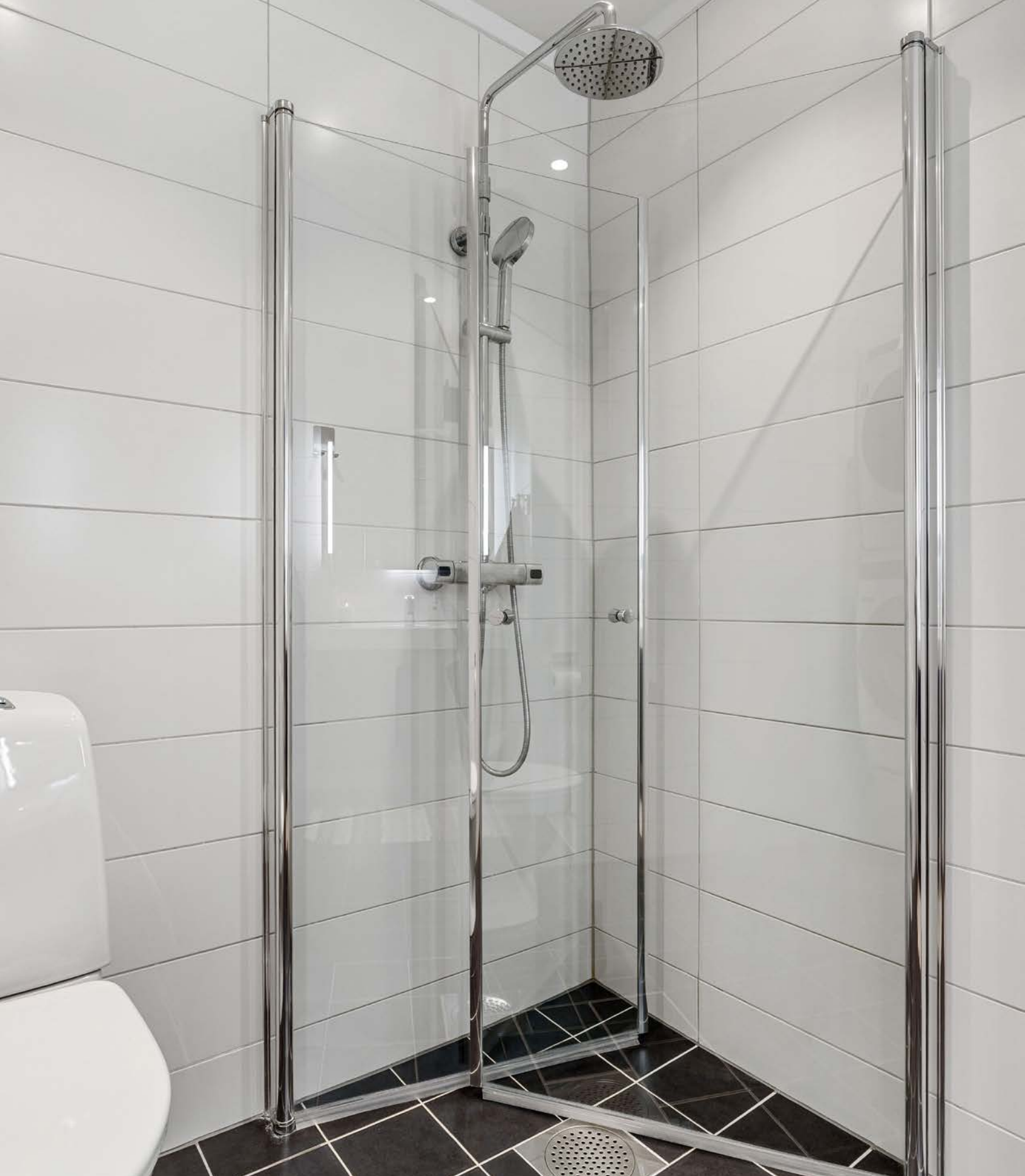
Dusjhjørne med innfellbare dusjdører med veggmontert dusjbatteri med regnfall og gulvmontert toalett.
