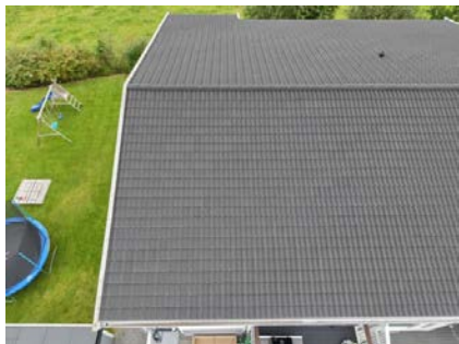
Taket er tekket med betongstein.
