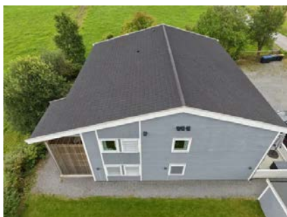
Boligen er oppført med saltakskonstruksjon.
