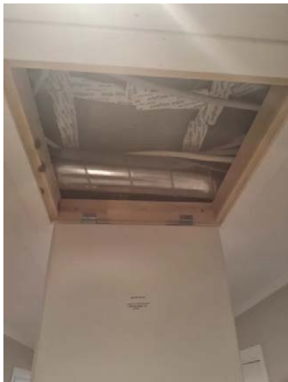
Inspeksjonsluke er plassert i gang.
