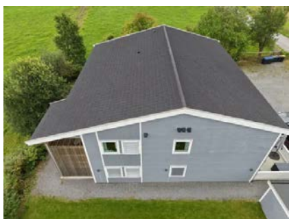
Boligen er oppført med 15 graders takvinkel og uten pipe, og det er derfor ikke behov for takstige eller snøfanger.
