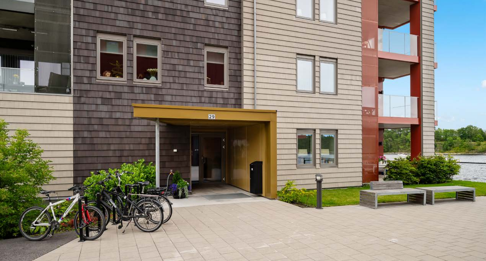
Felles overbygget inngangsparti. Pent opparbeidet med heller, sitteområde og gressplen
