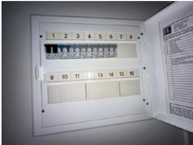
Sikringsskap med automatsikringer.
