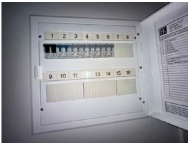
Sikringsskap med automatsikringer.
