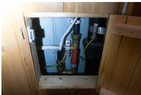
Bilde viser eksempel på avløpsrør av støpejern
