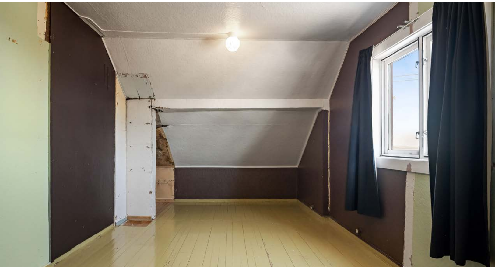
Soverom i 2. etasje. Rommet har lakkert tregulv som er delvis malte.
