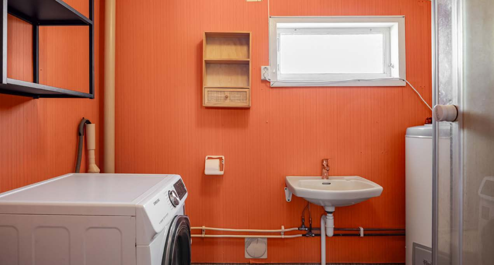
Eldre bad/vaskerom oppført en gang på 1970-tallet. Baderommet har belegg på gulv og våtromstapet på veggene.
