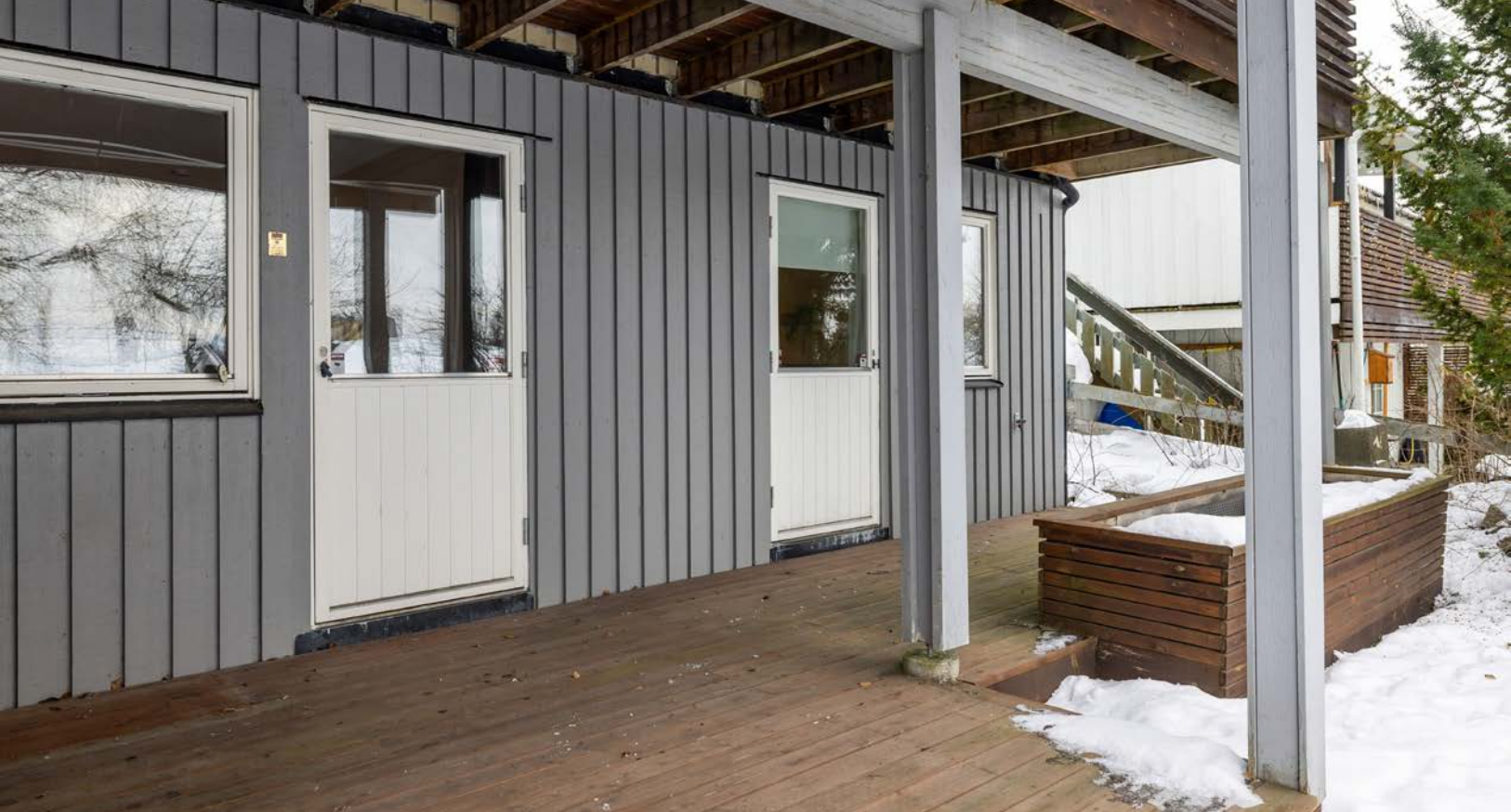
Både fra soverom 2 og 3 er det utgang til en overbygd terrasse på ca. 16m 2 mot syd.
