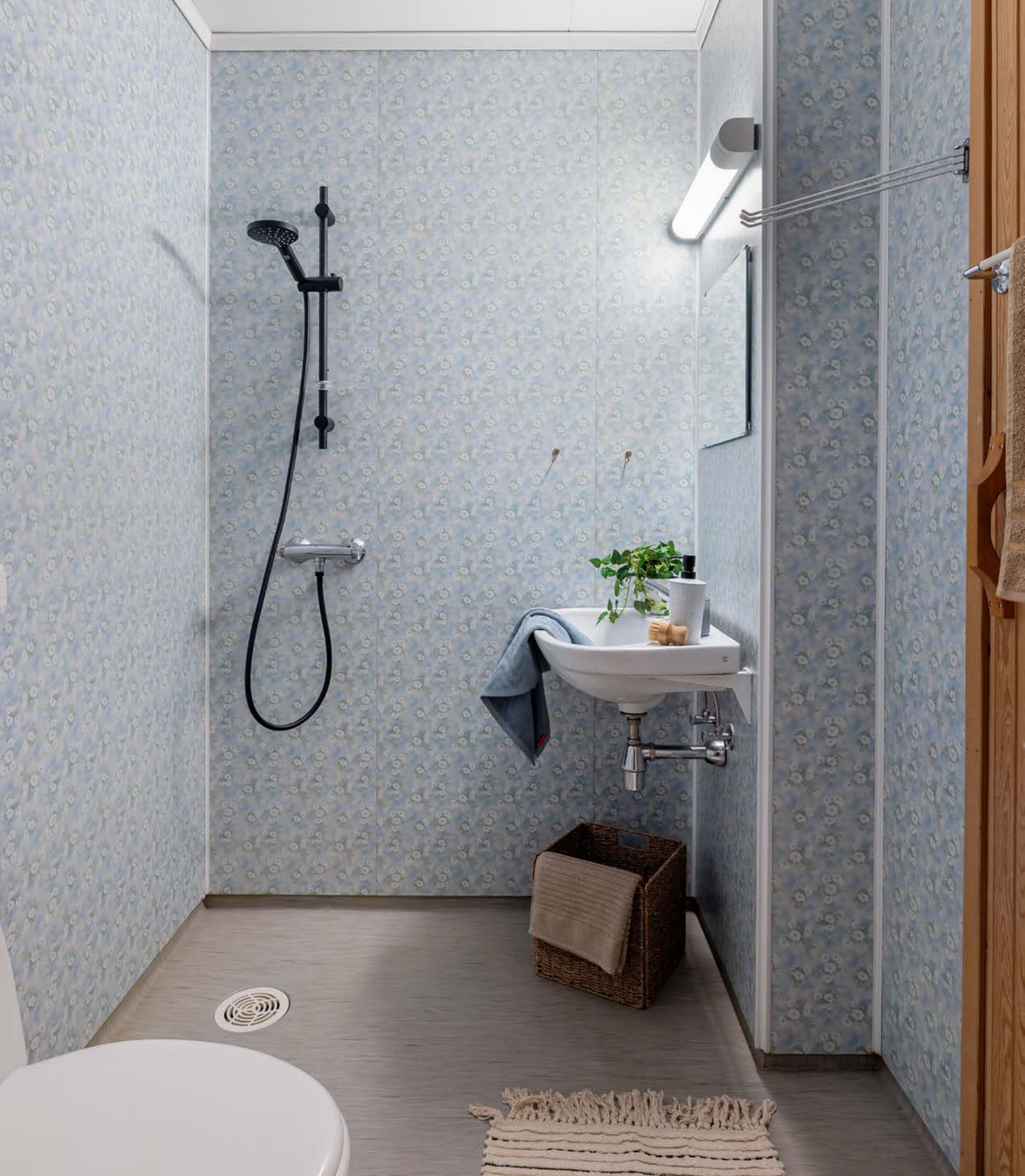
Baderom i underetasjen med vinylbelegg på gulv, elektrisk gulvvarme og våtromsplater på veggene. Baderommet er utstyrt med vegghengt servant med speil og belysning over, vegghengt dusj og gulvstående toalett. Det er også adgang til badstue. (Ikke montert oven).
