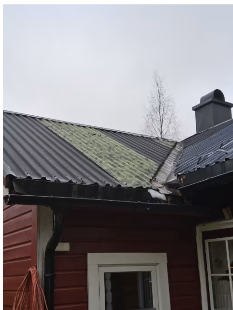
Bilde viser taktekking.
