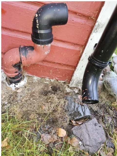
Bildet viser nedløp avsluttet over bakken.
