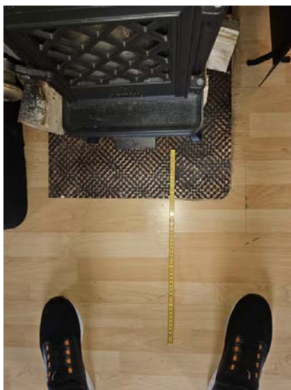
Bilde viser for liten ubrennbar plate.
