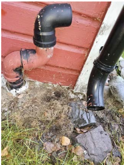
Bildet viser nedløp avsluttet over bakken.
