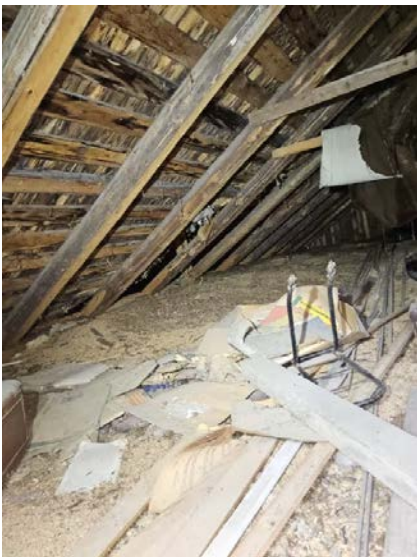
Bilde viser kaldtloft sett fra luke.
