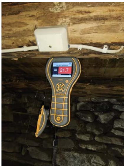
Bilde viser fuktmåling i etasjeskiller.
