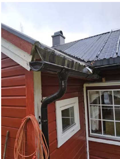
Bilde viser renner og nedløp.
