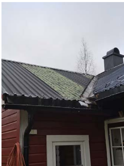
Bilde viser taktekking.
