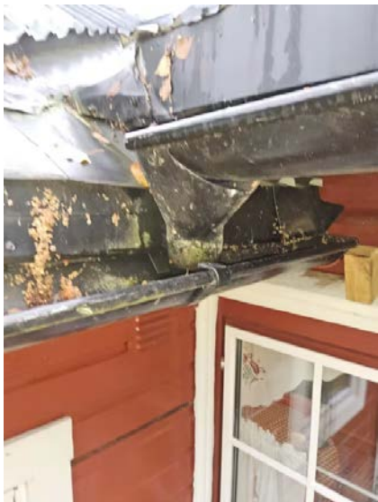
Bilde viser ufagmessig utførelse av renner.
