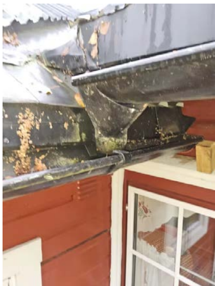
Bilde viser ufagmessig utførelse av renner.
