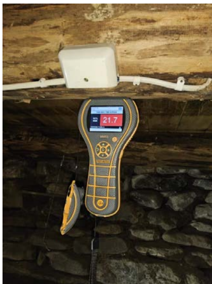
Bilde viser fuktmåling i etasjeskiller.
