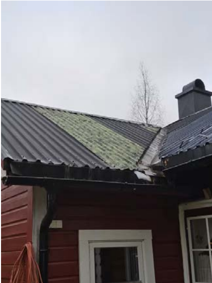
Bilde viser taktekking.
