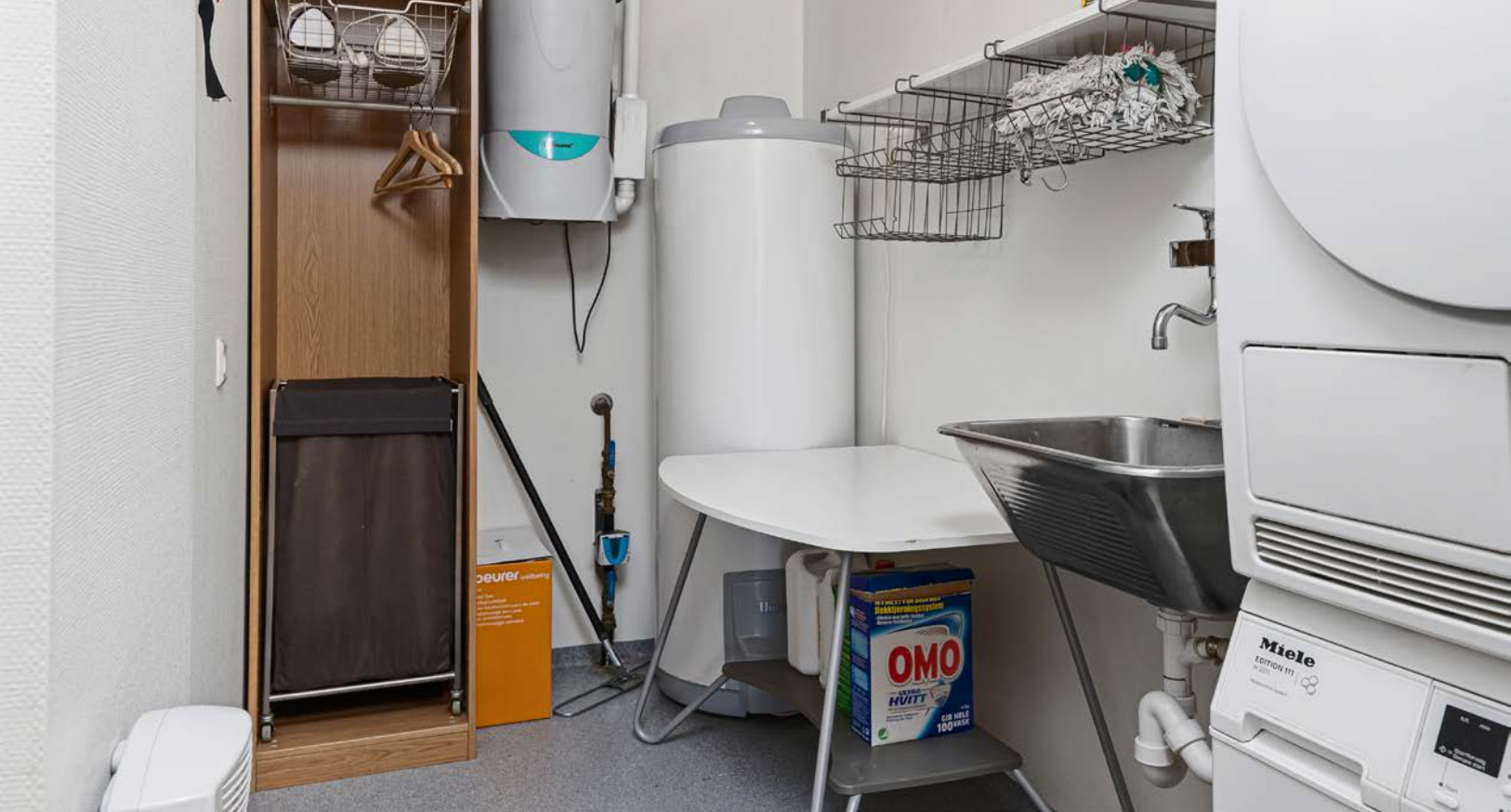
Vaskerom i underetasjen.
