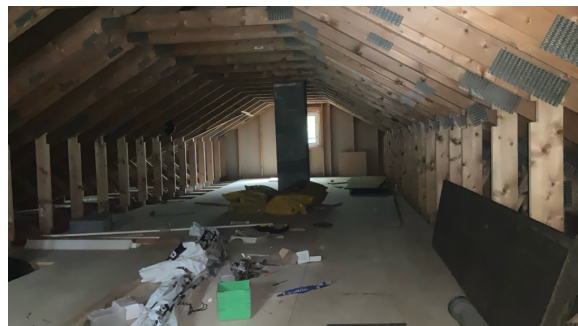
Loftet har begrenset ventilering. Ventilert i raft og gavl anbefales montert.
