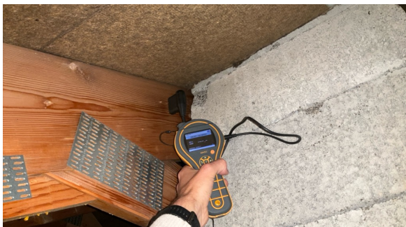
Ved fuktmåling registrerte jeg ikke unormale verdier.
