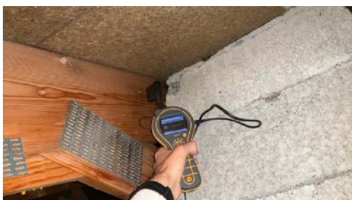
Ved fuktmåling registrerte jeg ikke unormale verdier.
