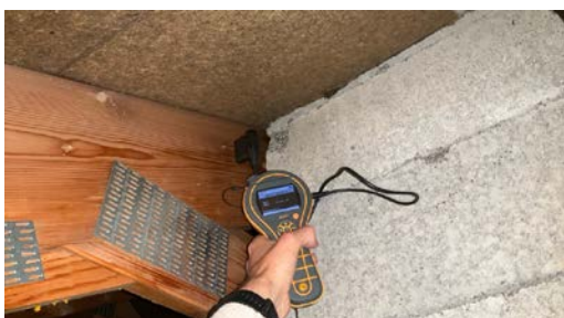
Ved fuktmåling registrerte jeg ikke unormale verdier.
