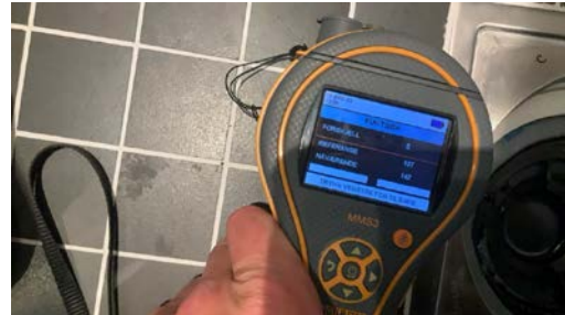
Gulv: Ved bruk av fuktindikator på utsatte steder registrerte jeg ikke forhøyde verdier.
