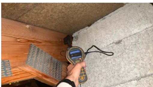
Ved fuktmåling registrerte jeg ikke unormale verdier.
