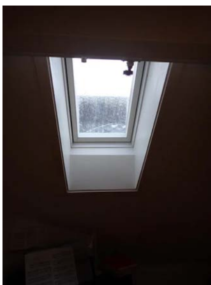
Sprekk i glass i takvindu.
