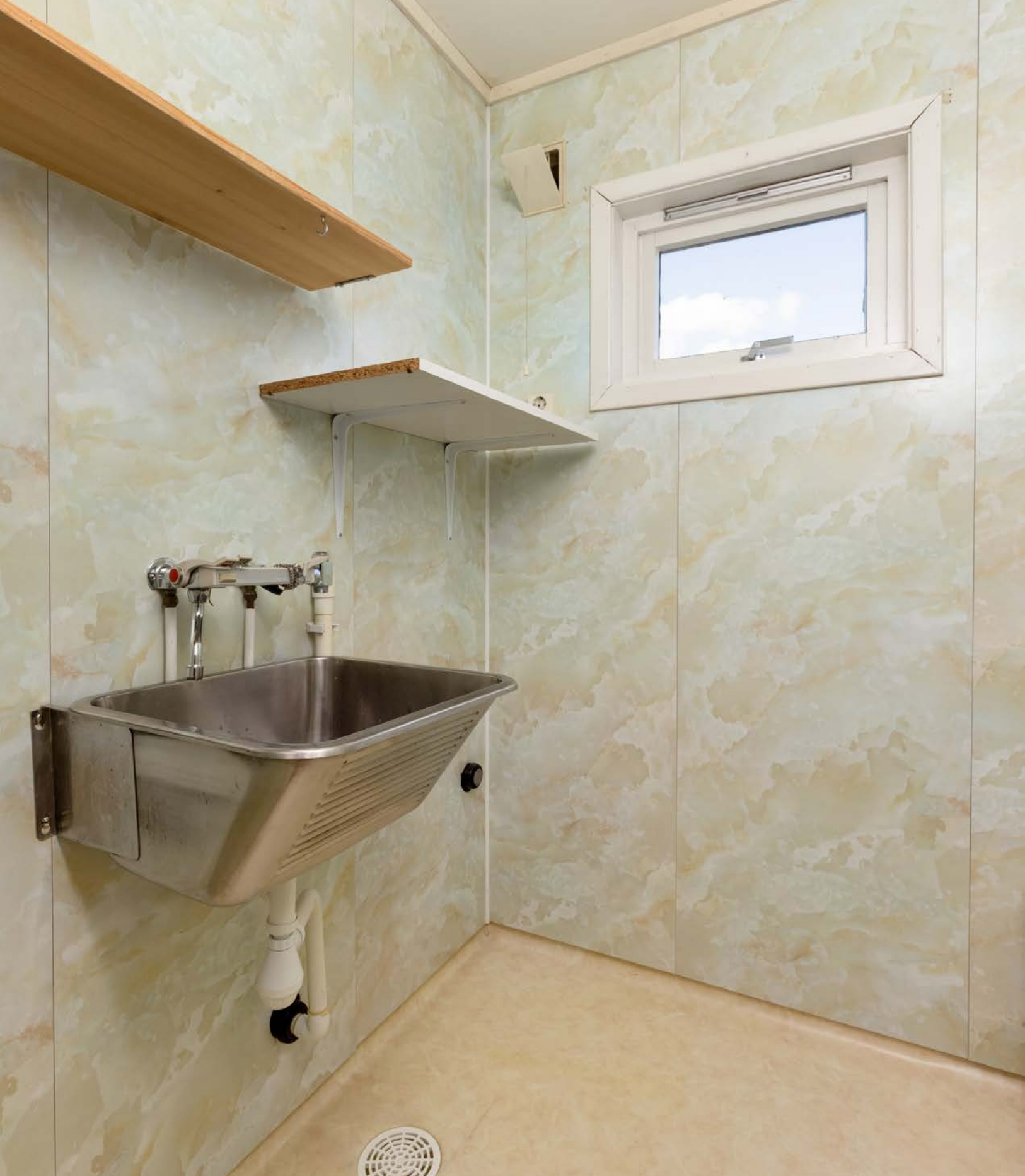
Eldre vaskerom i 1. etasje med opplegg for vaskemaskin.
