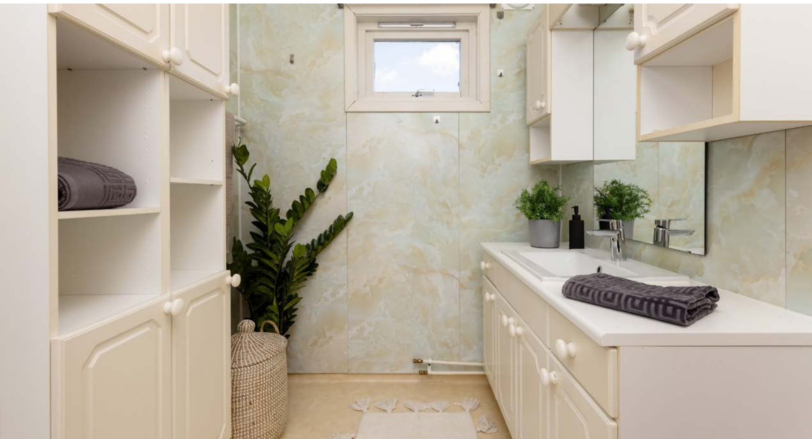
Eldre badrom med våtromsbelegg på gulv og overflater med våtromsplater.
