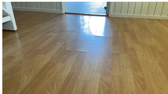
Svellinger registrert i laminatgulv.
