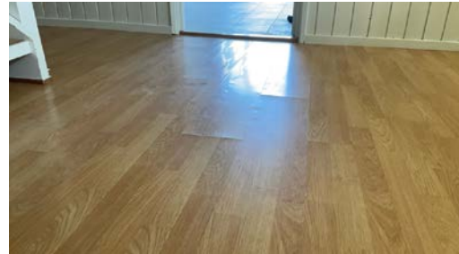
Svelling registrert i laminatgulv.
