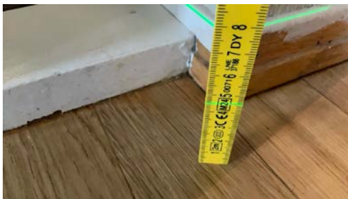
Noe ufagmessig utførelse på gulv.
