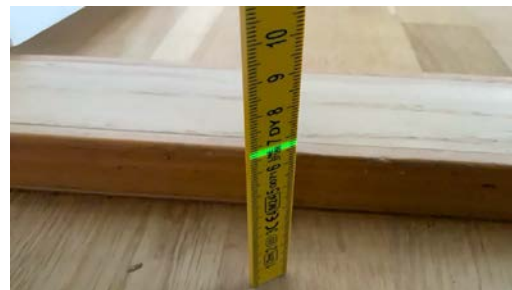
Svelling registrert i laminatgulv.
