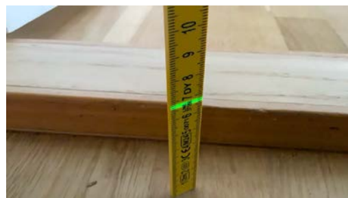
Svelling registrert i laminatgulv.
