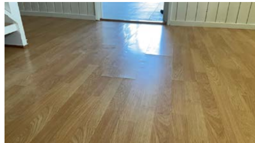
Svelling registrert i laminatgulv.
