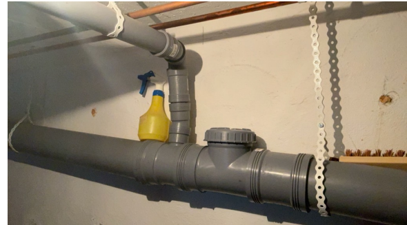
Stakepunkt i kjeller.
