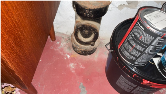
Stakepunkt i kjeller.
