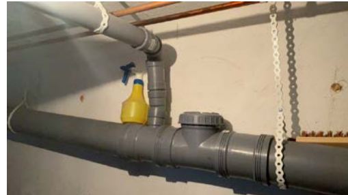
Stakepunkt i kjeller.
