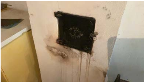
Sotluke i kjeller.
