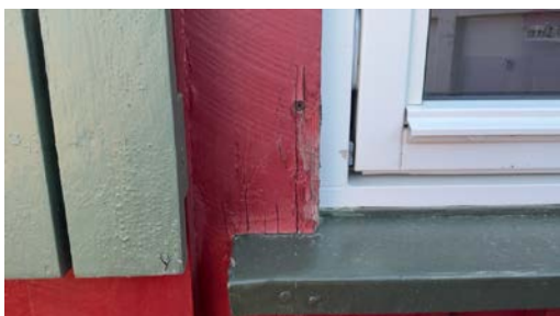
Omramming ført helt ned på vannbrett
