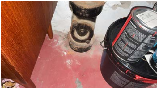
Stakepunkt i kjeller.
