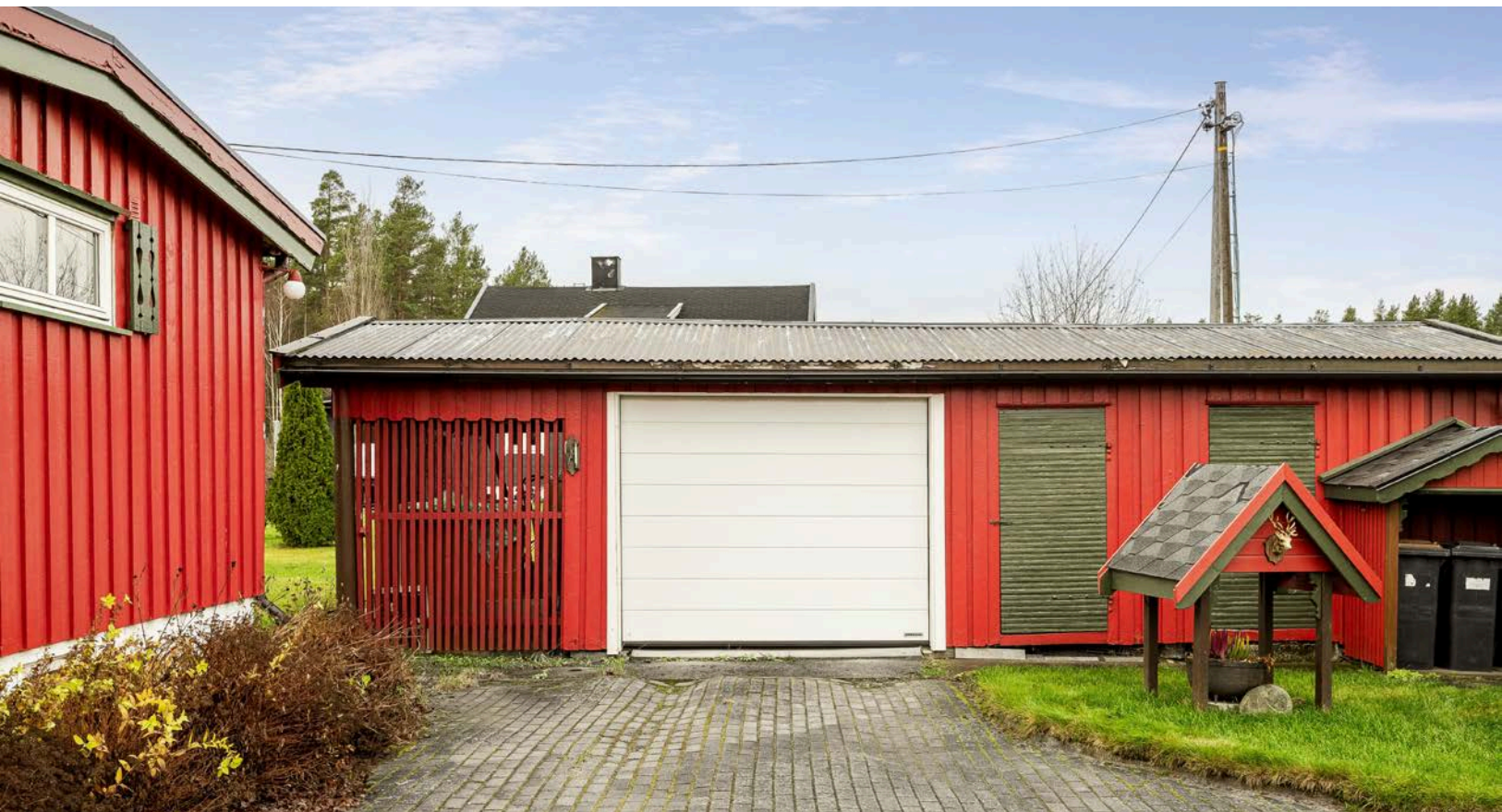
Garasjen er ca. 41 m 2 og oppført med trekonstruksjon og har betonggulv samt elektrisk foldeport.
