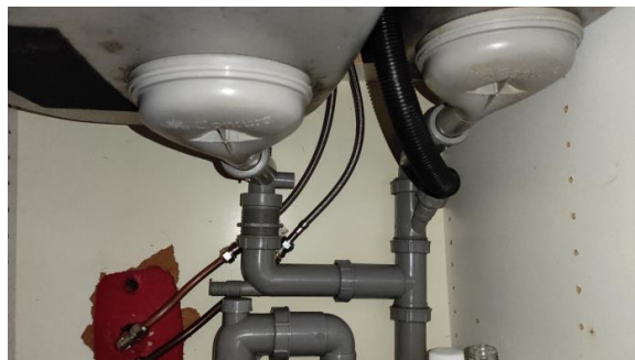
Kontroll av røropplegg.
