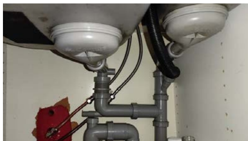
Kontroll av røropplegg.
