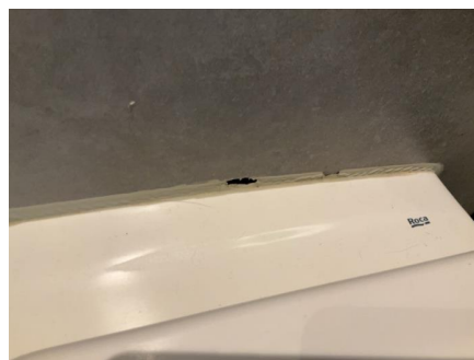
Sprekker i fuge bak/over vegghengt toalett.
