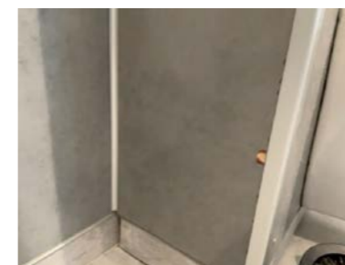
Avskalling på baderomsplate på dokasse.
