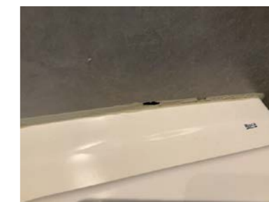
Sprekker i fuge bak/over veggengt toalett.
