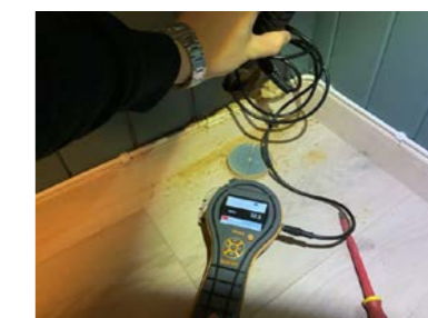
Hulltaking i hjørne mot vest i underetasje.
