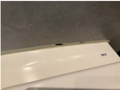
Sprekker i fuge bak/over vegghengt toalett.
