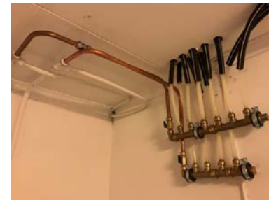
Nyere plast- rør i- rør fra samlestock på teknsik rom til utstyr i 1. etasje.
