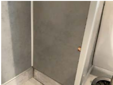
Avskalling på baderomsplate på dokasse.
