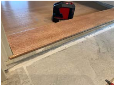
Synlig membranoppkant.
