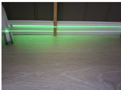
Etasjeskille er kontrollert med nivelleringslaser.
