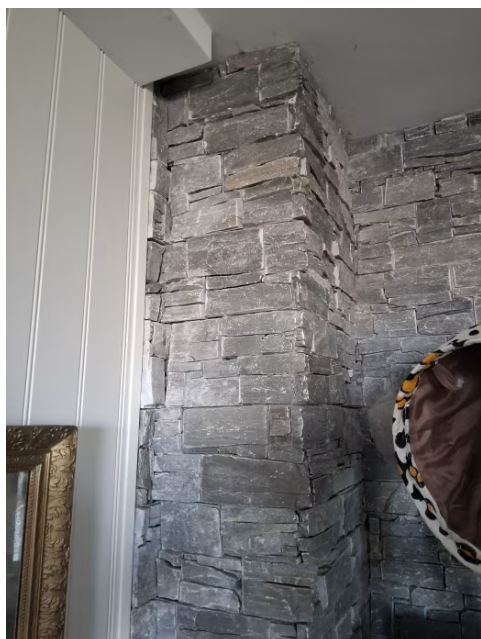
Pipen er forblendet med skiferstein i stue.
