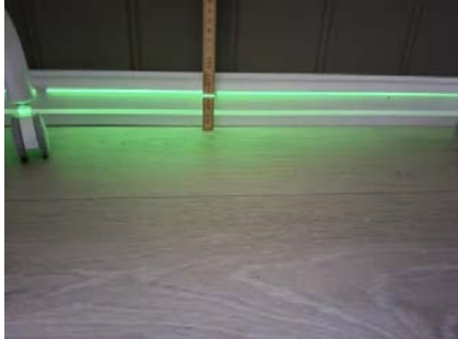
Etasjeskille er kontrollert med nivelleringslaser.
