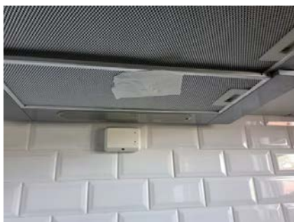
Avtrekkseffekt er testet med papir.
