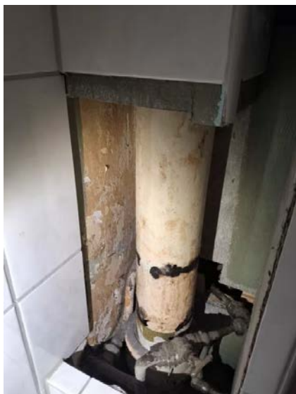
Synlige avløpsrør av støpejern.
