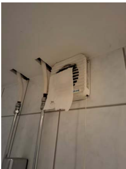
Avtrekkseffekten er testet med papir.
