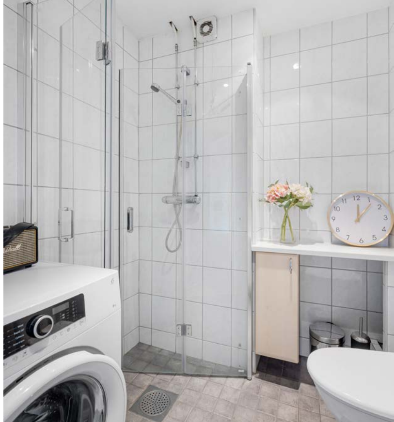
Dusjhjørne med innfellbare dusjdører med vegghengt dusjbatteri.
