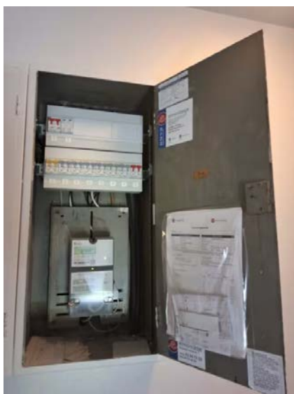
Sikringsskap er plassert i felles trappeoppgang.
