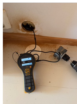
Hulltaking og fuktmåling bak dusjkabinett
