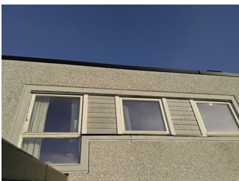
Bilde av tak fra bakkenivå
