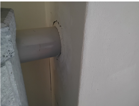
Bildet viser riss i pipe
