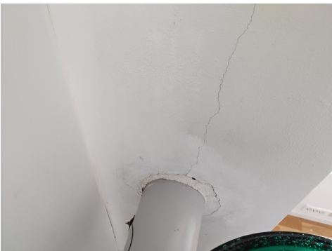
Bildet viser riss i pipe
