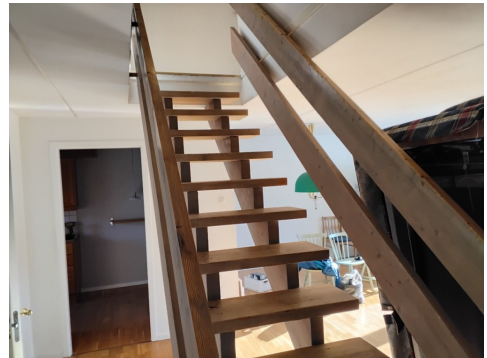
Trapp opp til 2 etg
