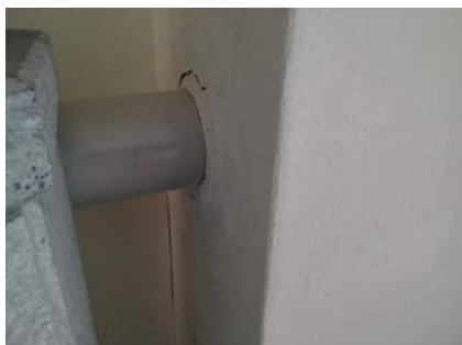
Bildet viser riss i pipe
