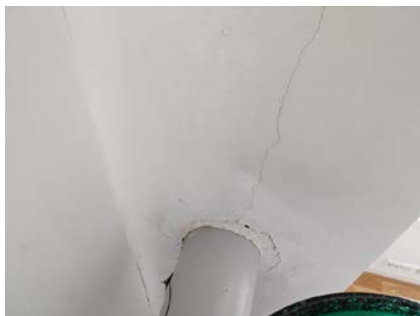
Bildet viser riss i pipe
