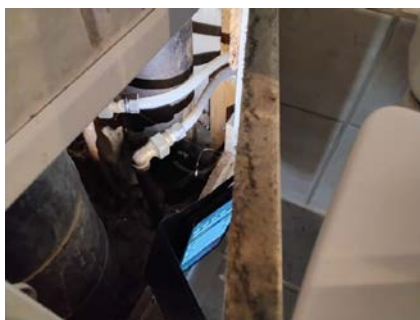
Røropplegg inne i kasse på badet
