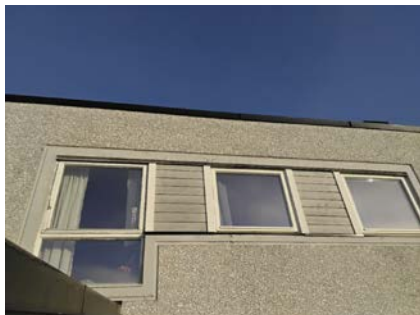
Bilde av tak fra bakkenivå
