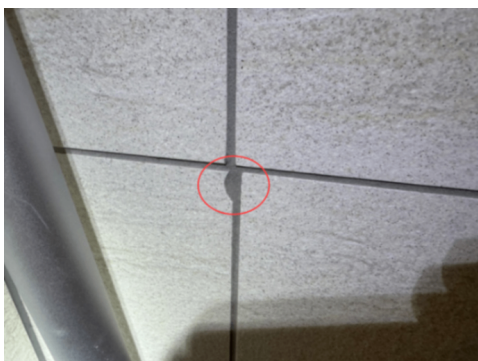
Foto viser kantskade i fliser på vegg.
