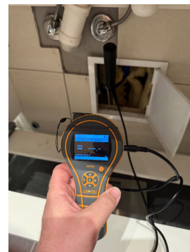
Foto: Fuktmåling i tilgjengelig trevirke.
