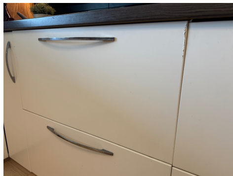
Foto viser eksempel på svelling av kjøkkenfronter.
