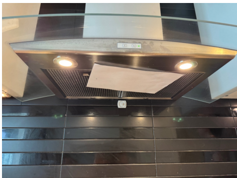
Foto viser test av avtrekk over platetopp.
