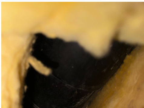
Foto: Visuell kontroll.
