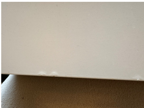
Foto viser eksempel på svelling på skuffefronter.
