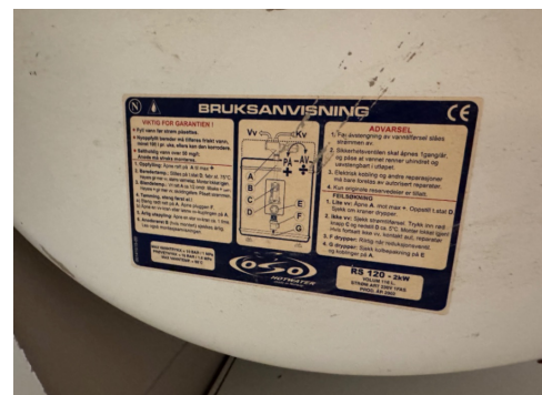
Foto viser bruksanvisning/ infoskjema på varmtvannstanken.
