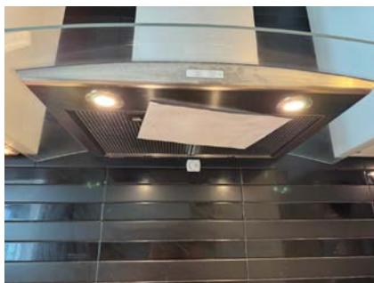
Foto viser test av avtrekk over platetopp.
