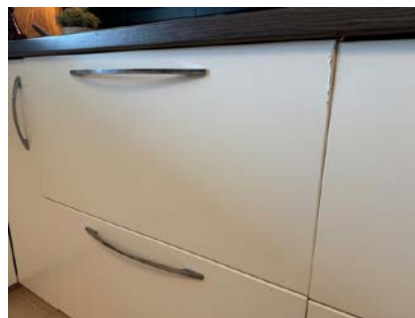
Foto viser eksempel på svelling av kjøkkenfronter.
