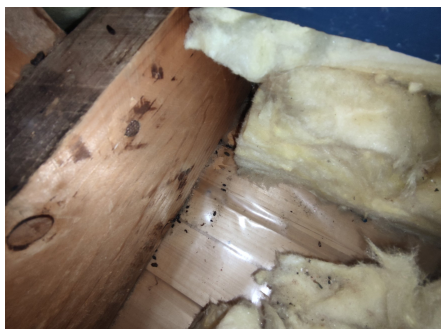
Punktering av dampspærre og muselort.
