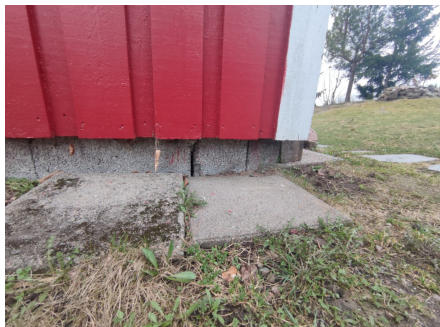
Lettklinkerblokker mot vei.
