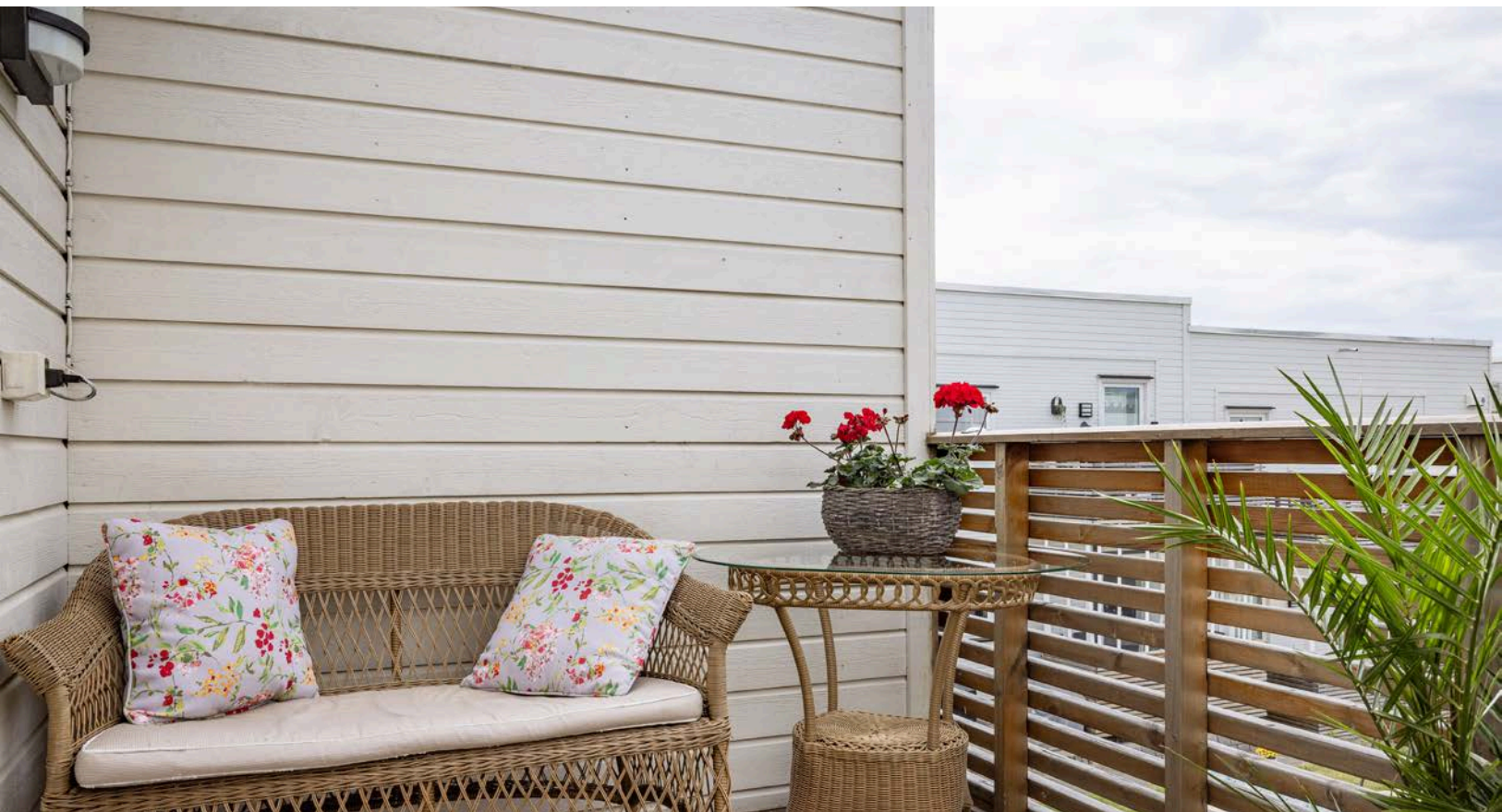
På balkongen er det montert utebelysning, stikkontakt og markise som fikk ny duk i 2023.
