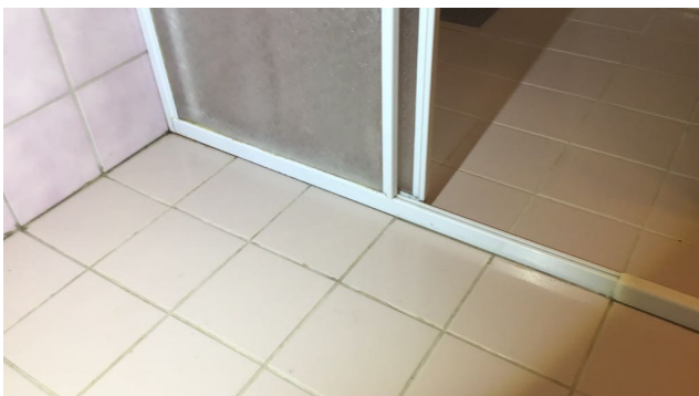
Tett oppkant rundt sluk
