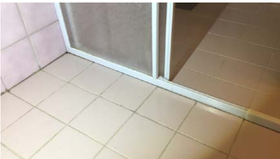
Tett oppkant rundt sluk
