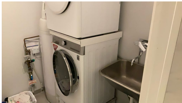
Vaskerom i forbindelse med bad.
