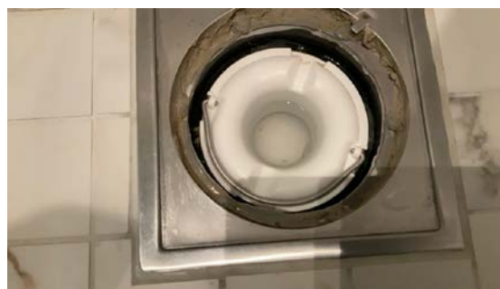
Sluk i dusjsonen
