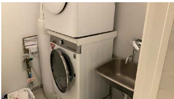
Vaskerom i forbindelse med bad.
