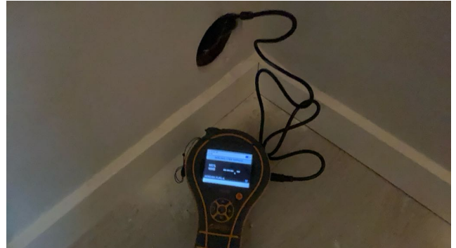
Fuktmåling i vegg under terreng.
