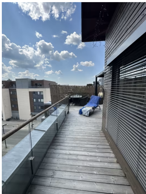
Viser glassrekkverk med håndløper i tre.
