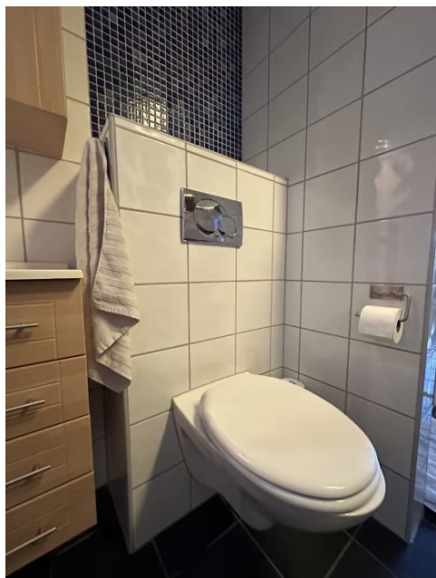
Viser vegghengt toalett med innebygget systerne.
