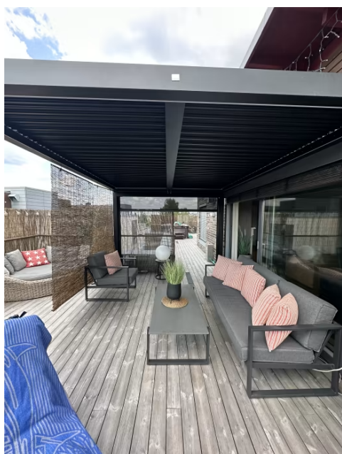
Montert pergola med elektriske screens.
