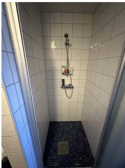
Viser dusjnise med foldevegg i glass og termostadbatteri med dusjgarnityr.
