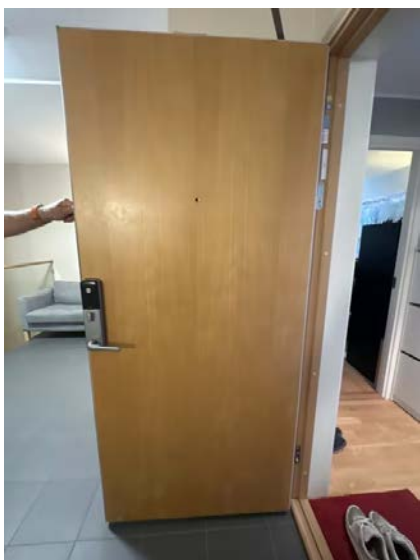
Viser brann-/lydklassifisert ytterdør med kikkehull, og smart dørlås.
