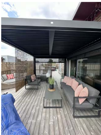
Montert pergola med elektriske screens.
