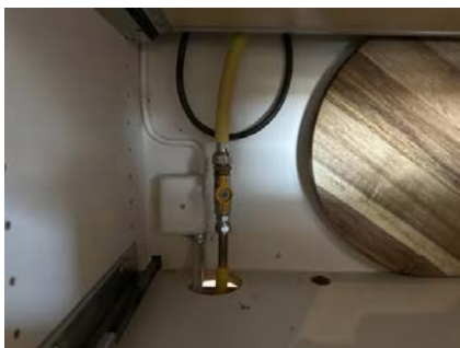
Viser stengekran for gass til platetopp.
