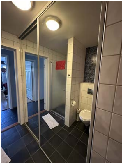
Bereder plassert bak skyvedører på bad.
