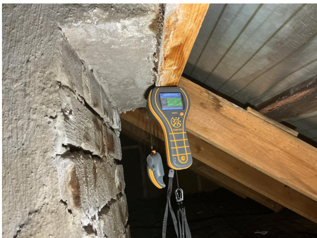
Feil utførte takgjennomføringer (pipe og ventilasjon).
