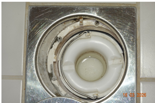
LEILIGHETEN I 3. ETASJE > BAD/VASKEROM
