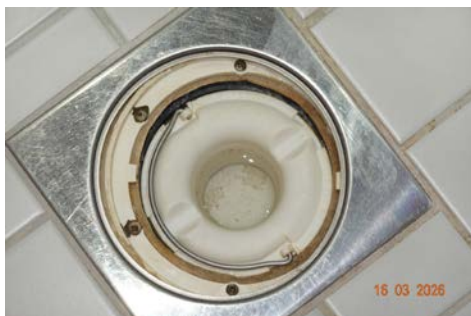
LEILIGHETEN I 3.ETASJE > BAD/VASKEROM
