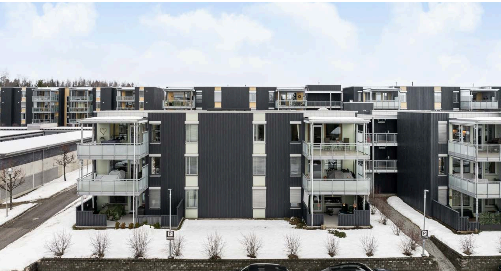
Leiligheten ligger i byggets 3. etasje.
