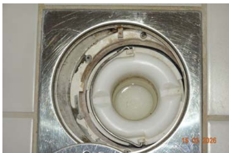
LEILIGHETEN I 3.ETASJE > BAD/VASKEROM
