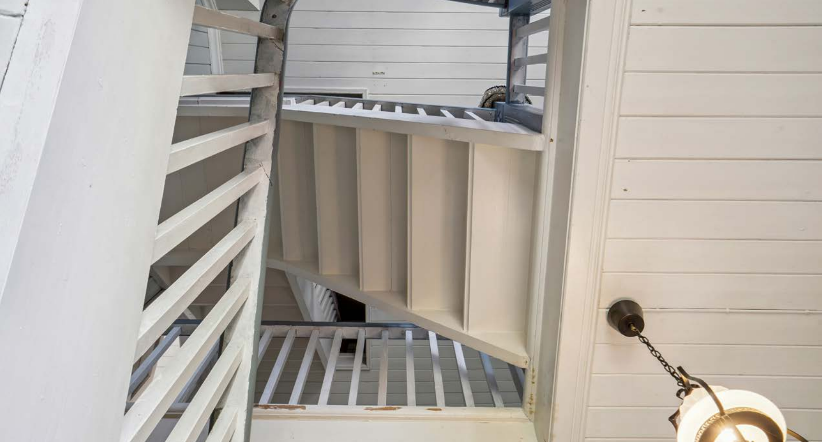
Den solide, gamle trappen er bevart i sin opprinnelige stil.
