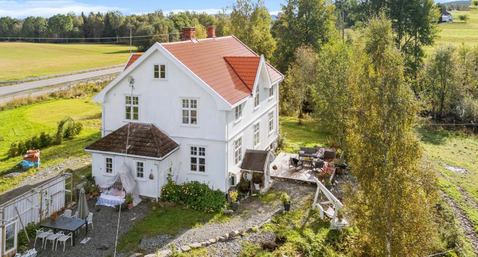
Utvendig er huset malt på nytt og det er lagt nytt tak i 2024 (med unntak av tilbygg).
