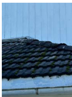
Gammel takstein på tilbygget bod og kjøkkeninngang.
