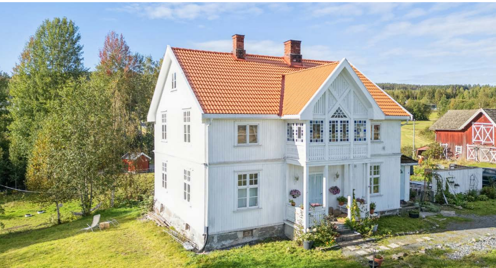
Grunnmuren er restaurert og forsterket av tradisjonshåndverkere, samt drenert på nytt i 2022.
