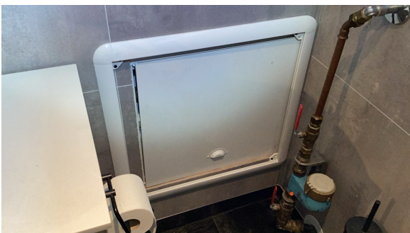
Fordelerskap er noe forskjøvet så sprutplate er vanskelig og få på plass.
